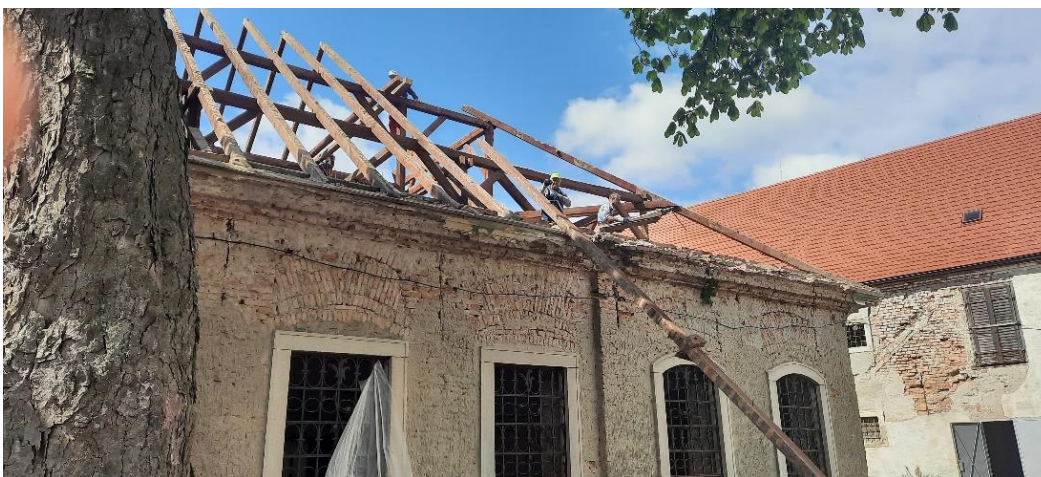
NKP Kaštieľ Čunovo počas rekonštrukcie
