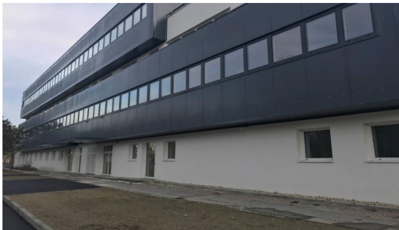
Zrekonštruovaný objekt na Harmincovej ulici č.1
