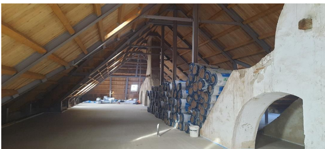
NKP Kaštieľ Čunovo počas rekonštrukcia
