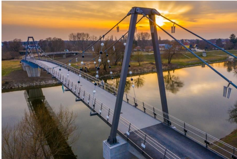
Osadenie ocelevej časti mostnej konštrukcie
