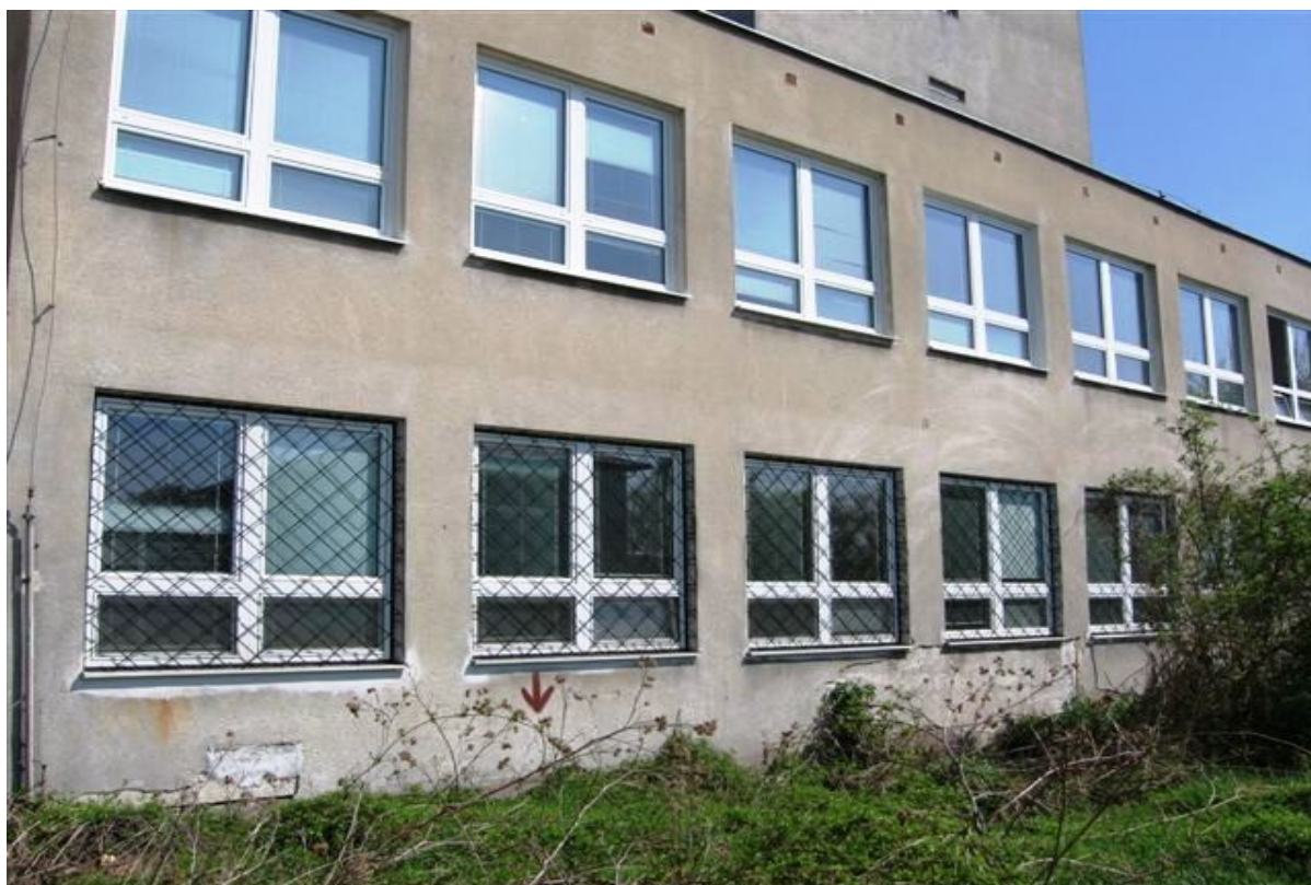
budova telocvične – Vranovská 2
