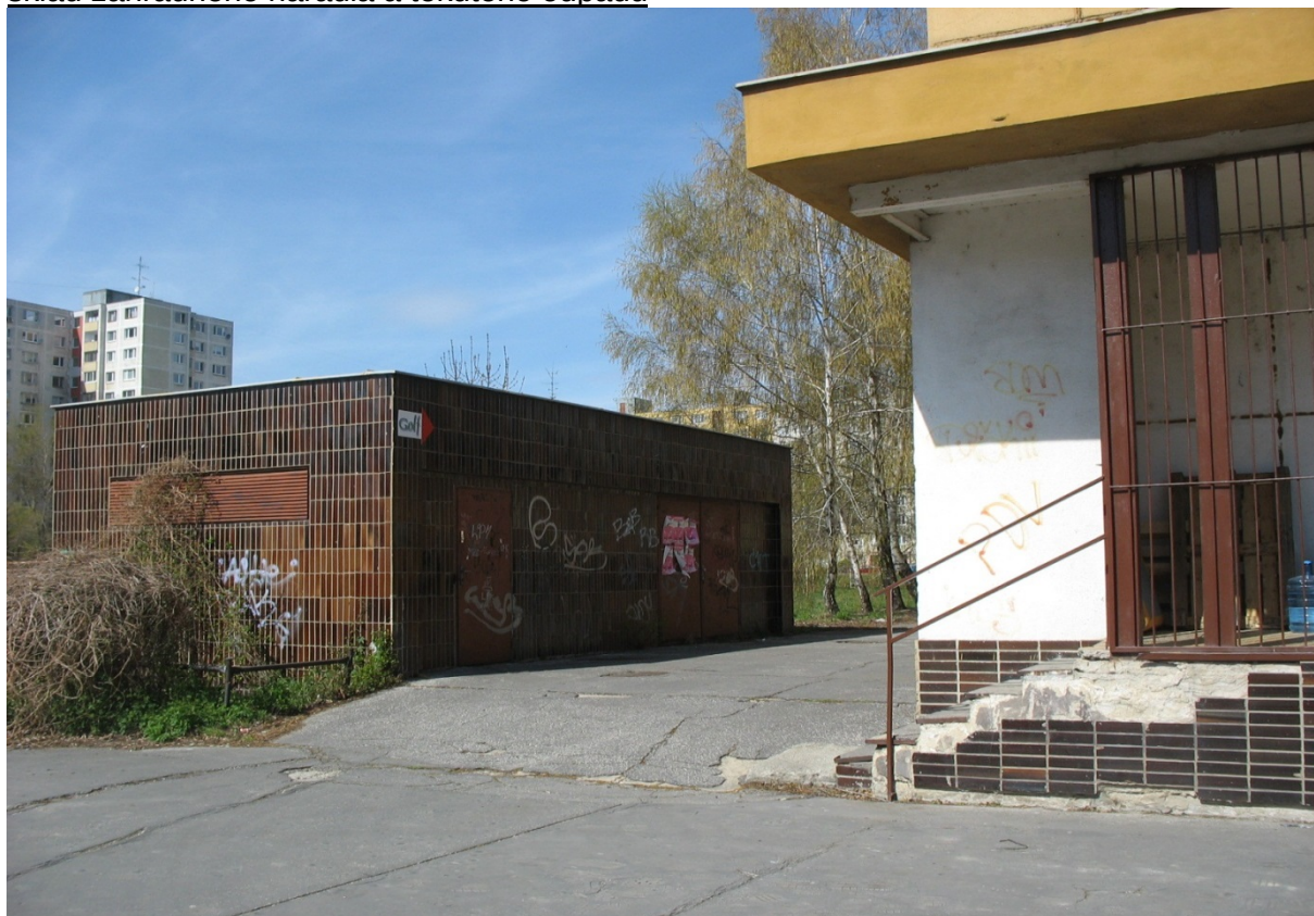
sklad záhradného náradia a tekutého odpadu
