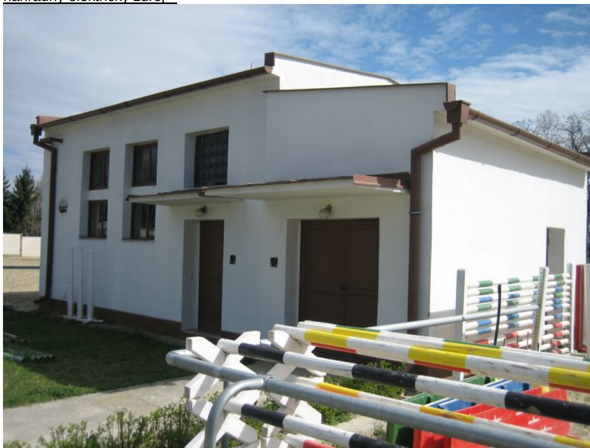
náhradný elektrický zdroj –
