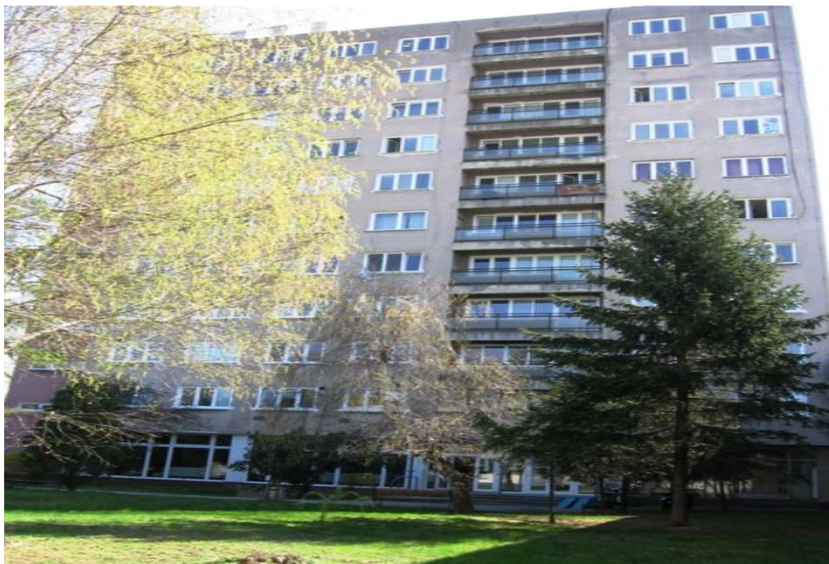
budova dielne – Údernícka, súp.č. 546
