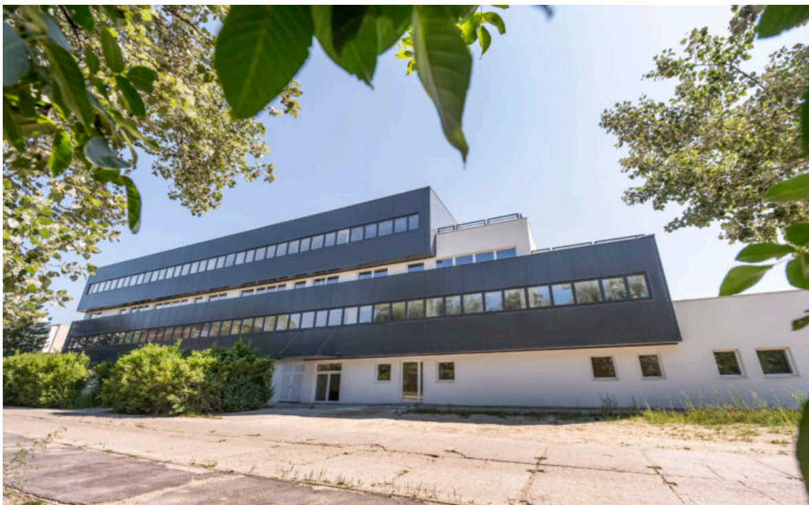
budova školy na Harmincovej ul. 1
