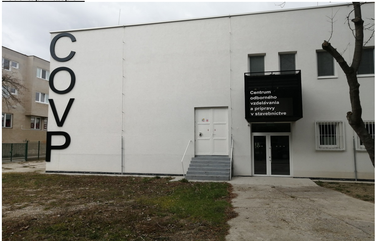
Budova po zateplení
