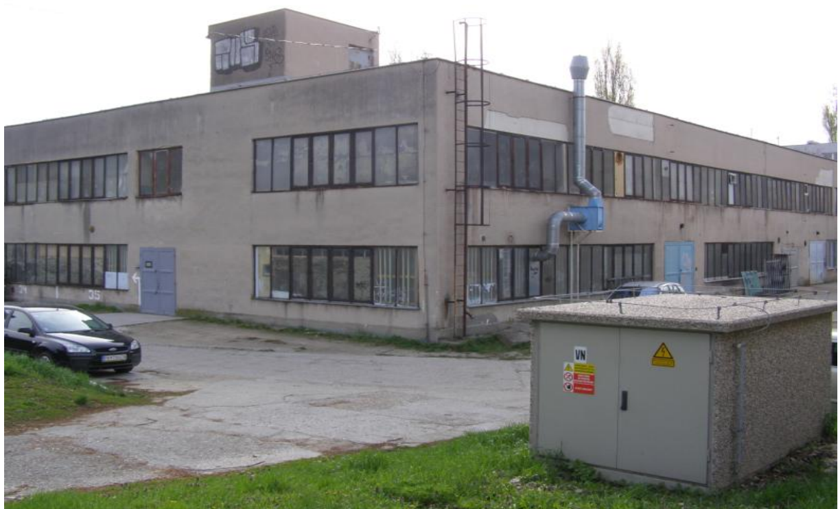
budova dielni – súpisné číslo 5795- pred zateplením
